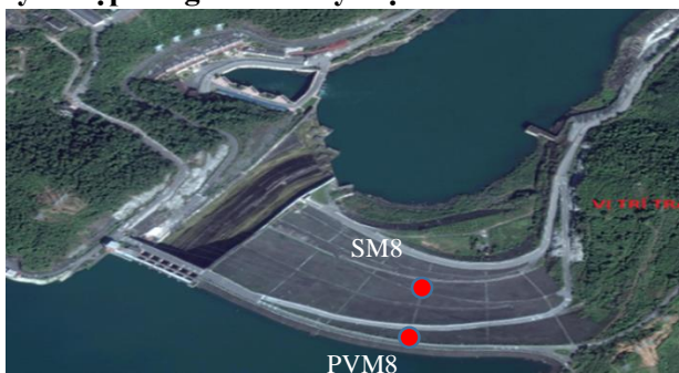
Hình 4.2: Vị trí PVM8 và SM8 trên tuyến đập thủy điện Hòa Bình
